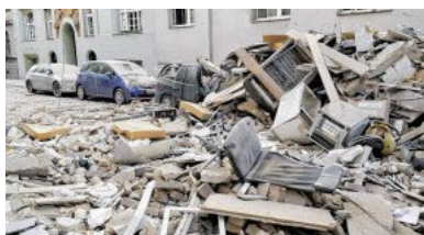
Vor dem Haus wurden Autos von Trümmern getroffen.
