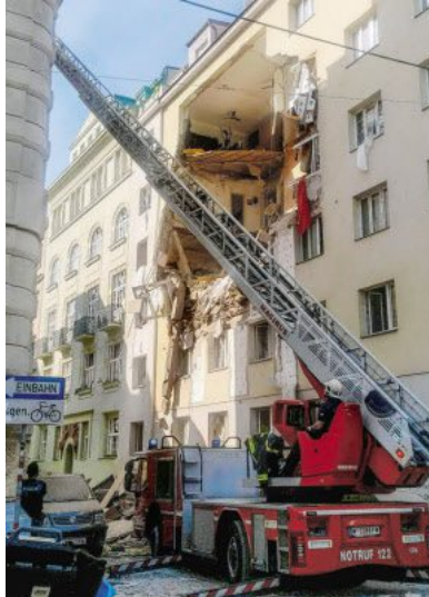
In der Hausfassade klawt ein riesiges Loch.
